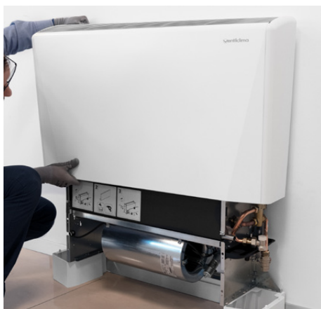
Fasi di manutenzione serie AIR-ECM-HY:
